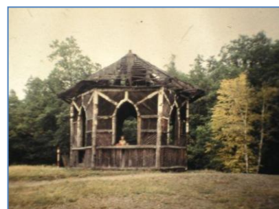
▲ Původní stavba vypadala trochu jinak.
