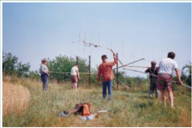
OK2KYK při stavbě antény
