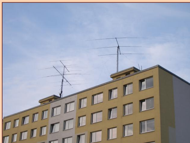
Obrázek 1 - Anténa v pracovní pozici na střeše panelového domu (výtahová šachta vlevo - nad 4 el. 15 m)
