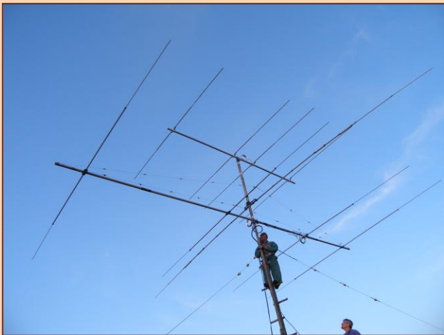
Obrázek 5 - Montáž za pomoci mých kamarádů OK1DSX a OK1FMX
