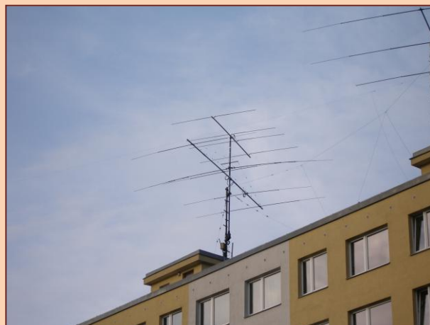
Obrázek 2 - Anténa v pracovní pozici na střeše panelového domu (nad 4 el. 15 m)
