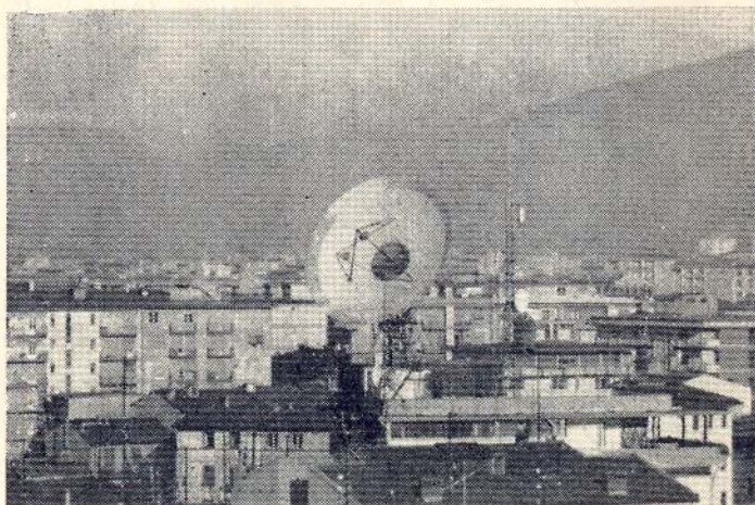
V běžné městské zástavbě instalovala svou parabolickou anténu o průměru 11 m ze spojení EME známá stanice I5MSH.
