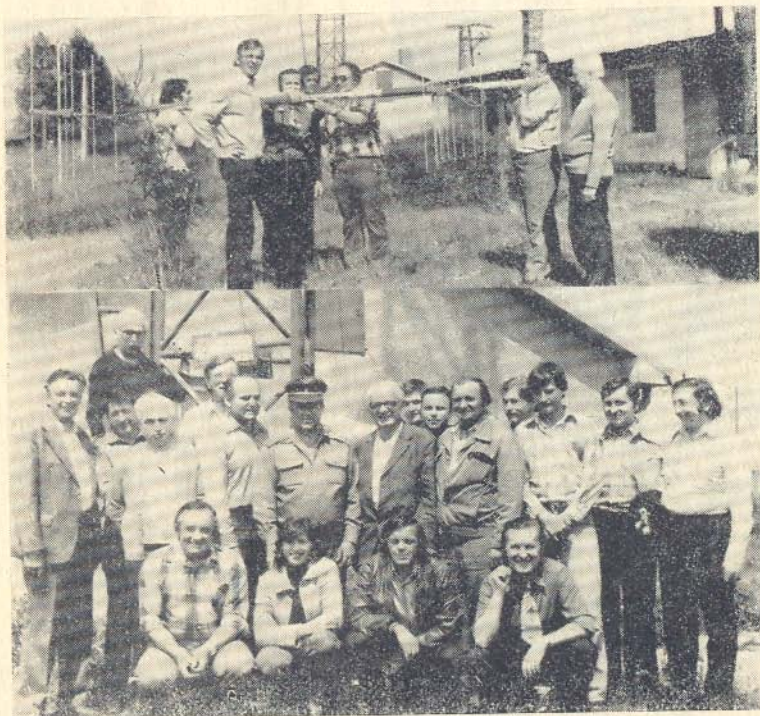
Na hornom snmku stavba antény VKV pri odbornom dohľade Ondreja OK3AU, dole sú účastníci stretnutia u jazera v klube OK3VSZ v Čani.
